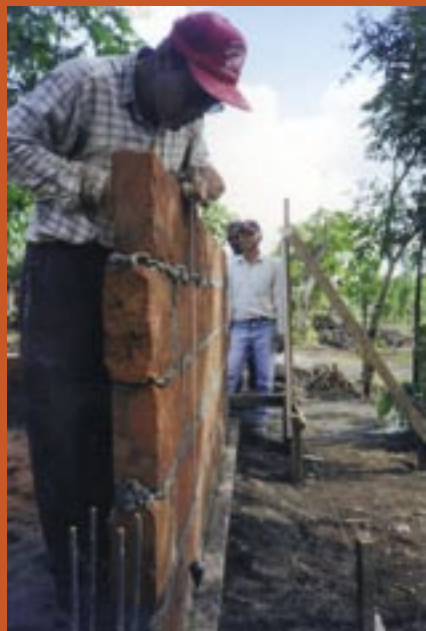
08/99 Construcción de 33 viviendas en Nicaragua.
