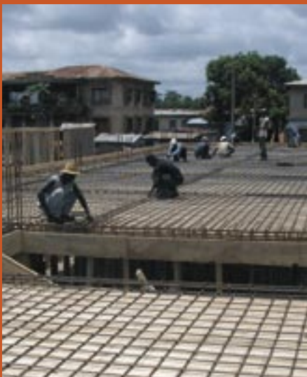
01/06 Derribo y reconstrucción de escuelas en Ghana.
